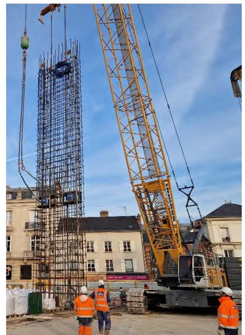
*Instalación de armaduras con disposición O-Cell*
